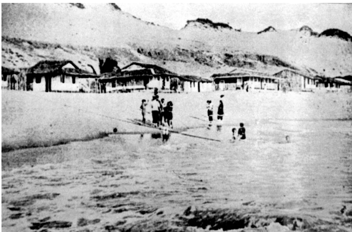
Figura 5: Vista parcial da Praia do Meio.
