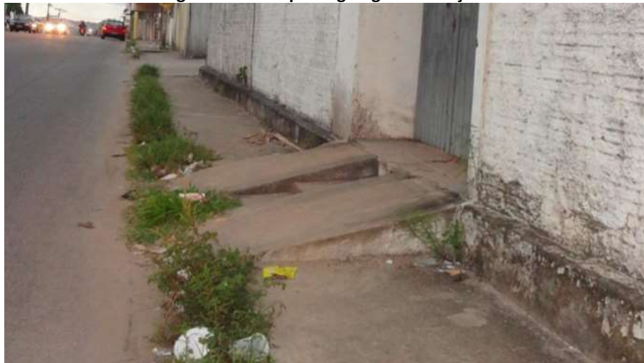
Figura 14 – Rampa de garagem na calçada
