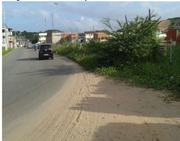
Figura 30 – Ausência de calçada na R. Antônio Freire Lemos
