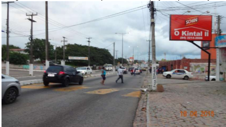
Figura 20 – Ausência de faixa de pedestre e inadequação do piso na calçada
