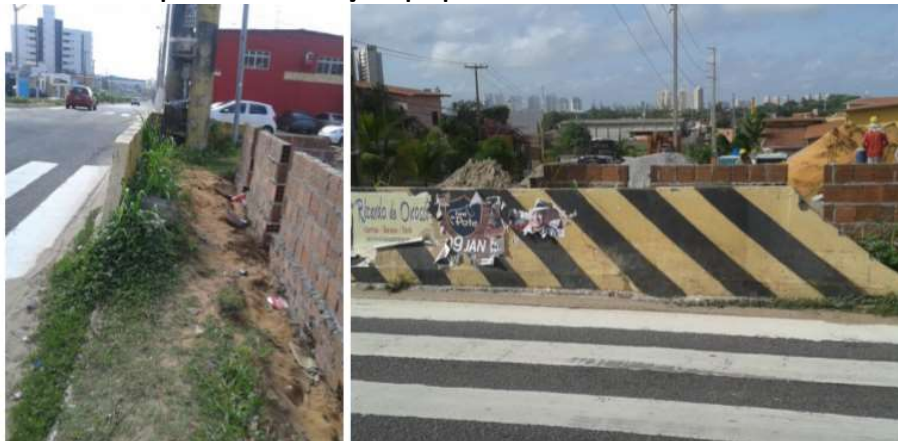
Figura 36 - Faixa de pedestre sem calçada perpendicular na Av. Tarcísio de Vasconcelos Maia
